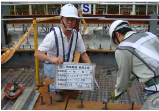
剪力釘敲擊檢測
