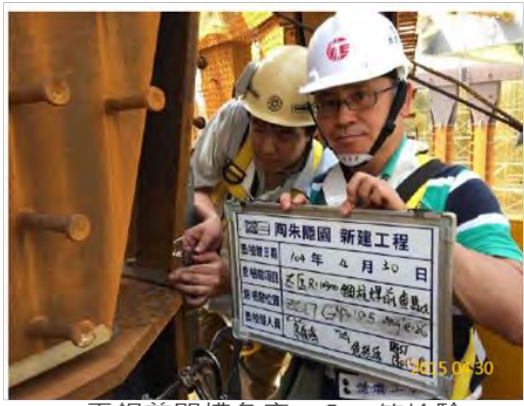
電銲前開槽角度、Gap等檢驗
