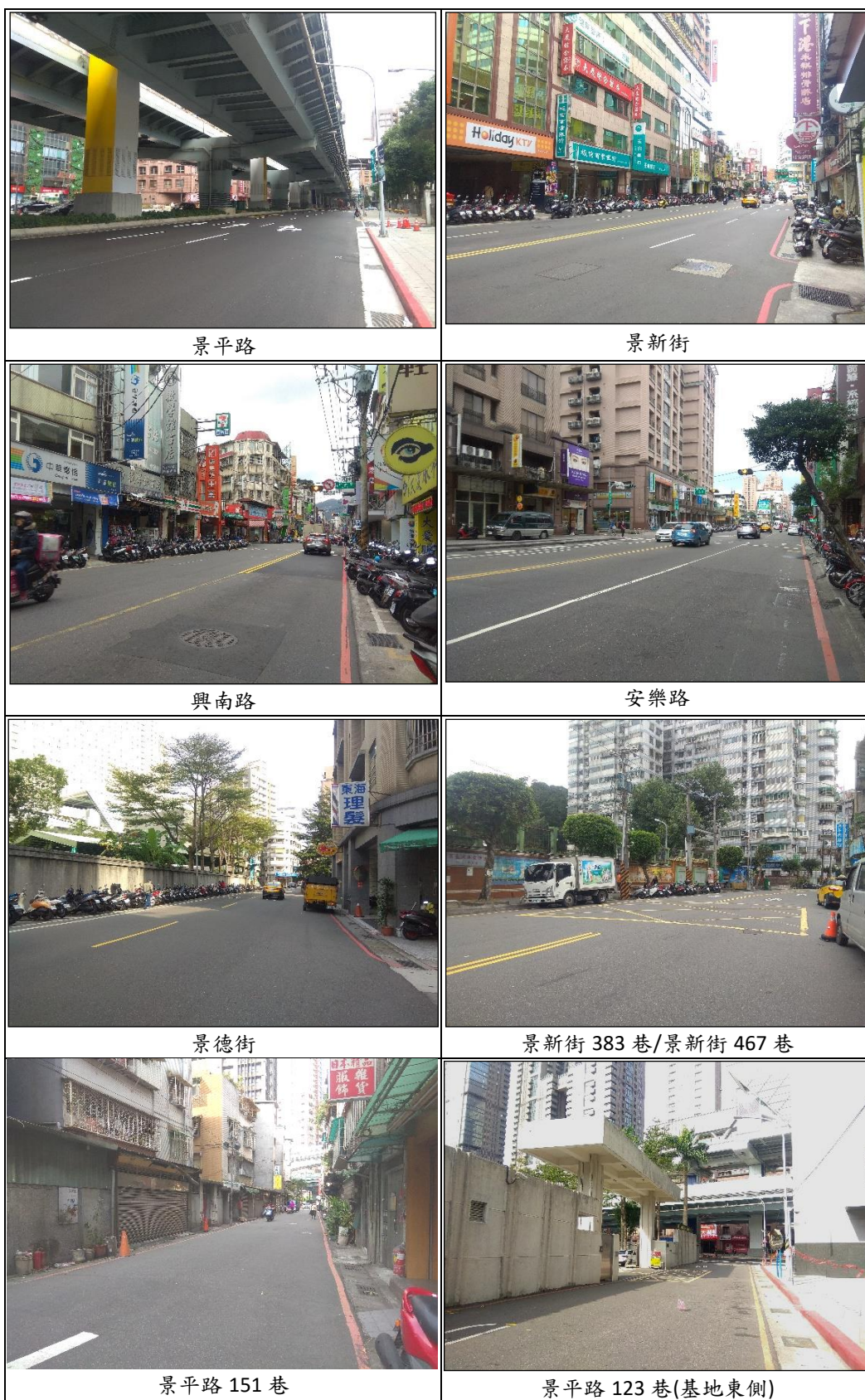
圖 1-18 更新地區附近主次要道路現況照片圖
