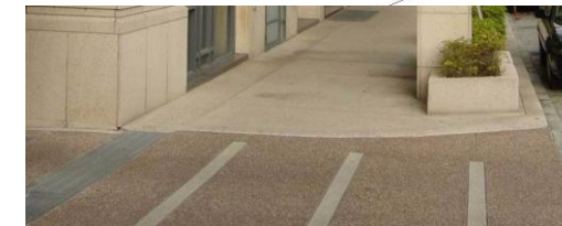
坡道與人行動線高差順平處理示意圖
