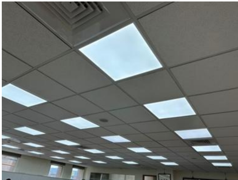
辦公室全面導入 LED 照明設備
