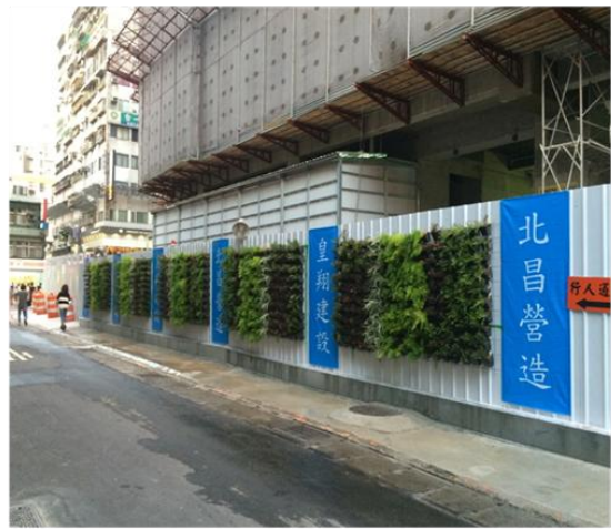
工地環保綠色植生圍牆之二
