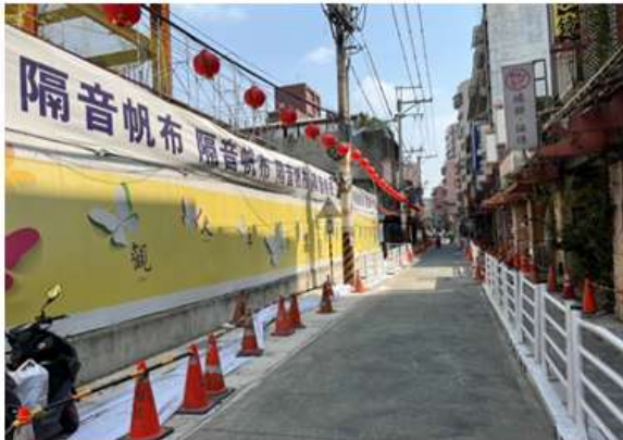
工地圍籬及施工噪音隔音帆布
