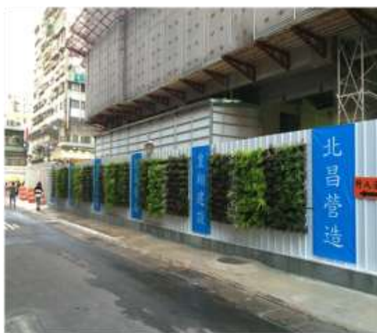
工地環保綠色植生圍牆之二
