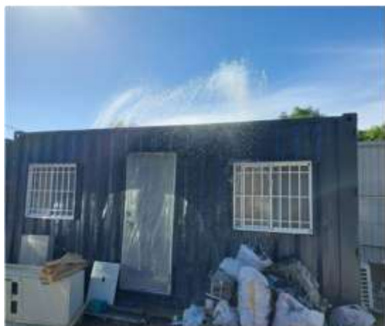
工務所屋頂的自動灑水設備
