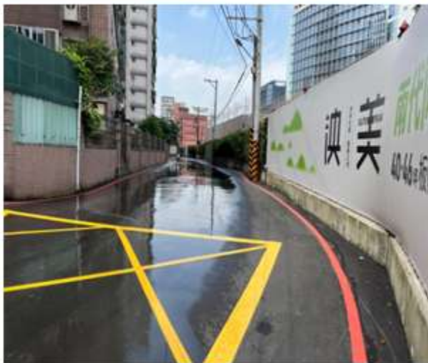
工地鄰近道路清洗
