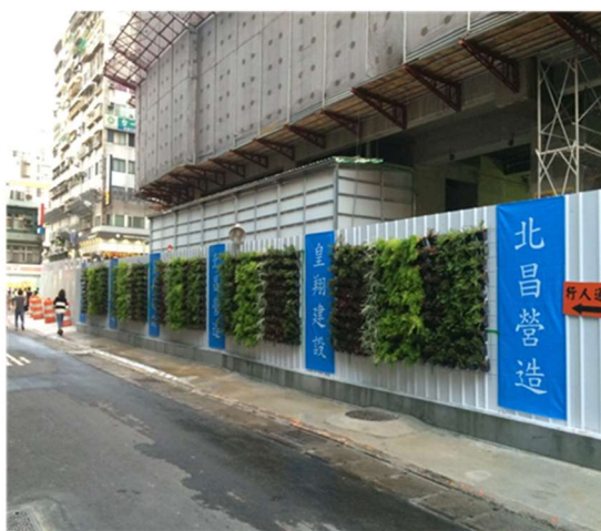
工地環保綠色植生圍牆之二
