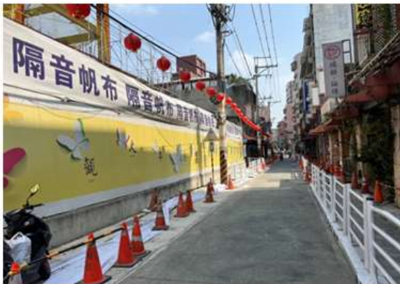
工地圍籬及施工噪音隔音帆布
