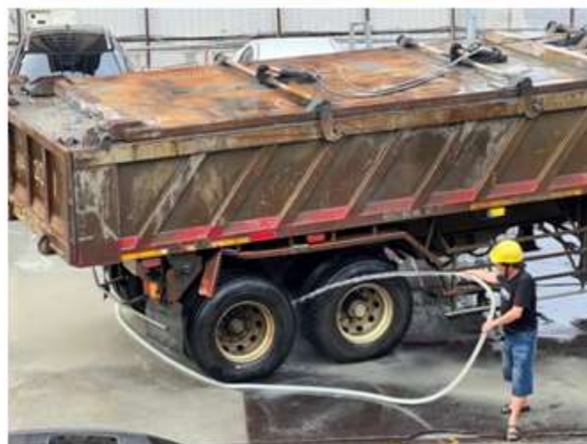
工地派水車清洗鄰近道路
