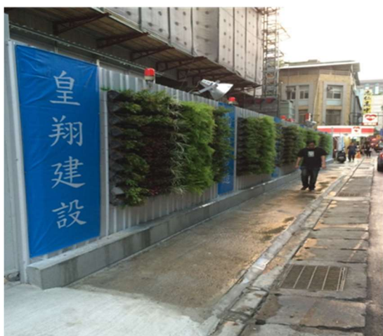
工地環保綠色植生圍牆之一
