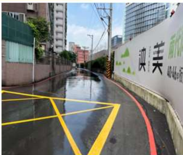
工地鄰近道路清洗
